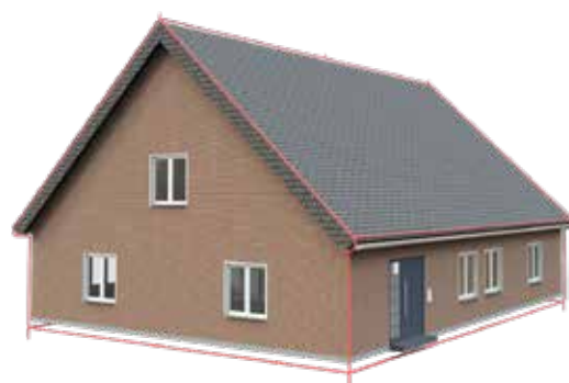
Dom z zewnętrzną instalacją odgromową
